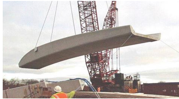
شکل ۱: نمونه هایی از کاربرد فروسیمان در سازه ها [۶]
