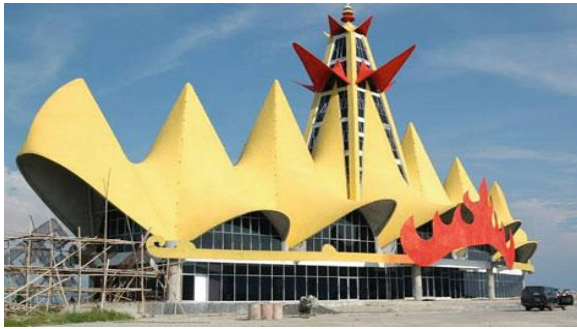
شکل ۱: نمونه هایی از کاربرد فروسیمان در سازه ها [۶]
