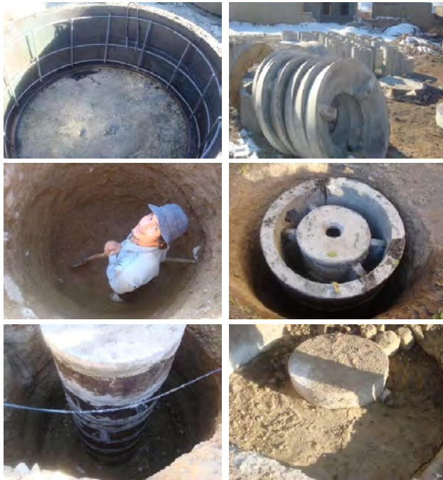
شکل ۲- مراحل اجرای سپتیک تانک
